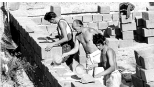
Svojpomocná stavba murovanej lodenice
